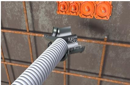
Tülle (M20-M25) oder Krümmer (M32-M40) öffnen und Installationsrohr einklicken.
