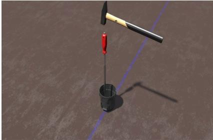
Montage Ortbeton: Universaldose mit Primo Nagler auf die Schalung nageln. Die integrierte Nagelfixierung ermöglicht eine einfache Montage.
