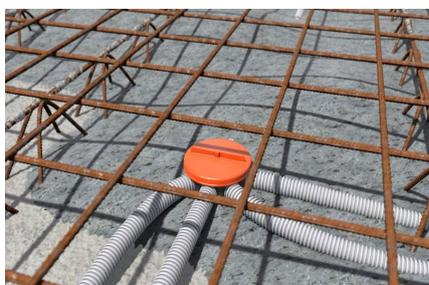
Deckel aufschrauben, Stahlarmierung legen und betonieren.
