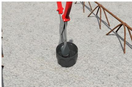
Deckel abschrauben und Einführungen für Installationsrohre M20/M25 mit einem Stufenschälbohrer oder einer Stanzzange öffnen.
