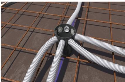
Installationsrohre einführen. Es können bis zu acht Installationsrohre M20 / M25 angeschlossen werden.
