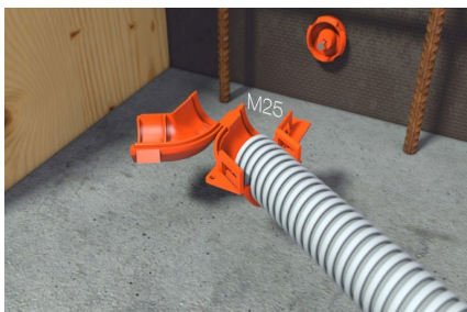
...Krümmer öffnen und M25 Installationsrohr einführen
