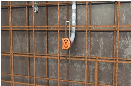
Frontteil aufstecken. Einfache Montage an der Stahlarmierung durch Flügel.
