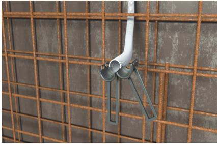
Tülle öffnen und M20 oder M25 Rohr befestigen.
